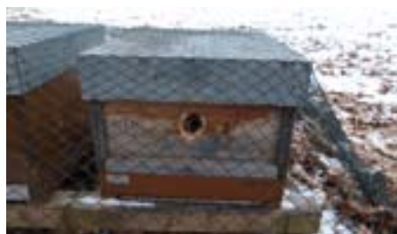
Abb. 03: Spechtschaden - zu spät erkannt.
