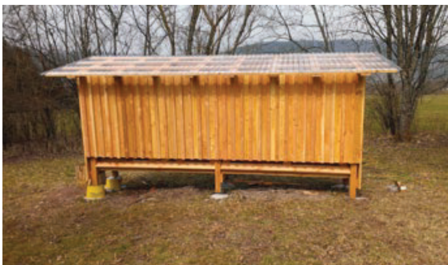
Der Vereinsstand während der Bauphase
