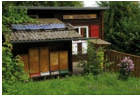
Abb. 01 - Lehrbienenstand des Imkerverein Ulm. Photovoltaik-Insellösungen werden unabhängig vom Netz betrieben. Sie eignen sich bestens für die Energieversorgung abgelegener Stellen – für die Elektrifizierung eines Imker-Häuschens, für das Betreiben elektrischer Geräte oder zur Beleuchtung.
