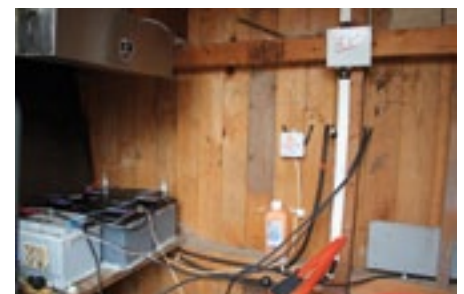
Abb. 03 - Das autarke Photovoltaik-System kann über 12 V oder mit einem Wechselrichter über 220 V betrieben werden. Alle Geräte bekommen ihre Energie unabhängig vom Stromnetz.
