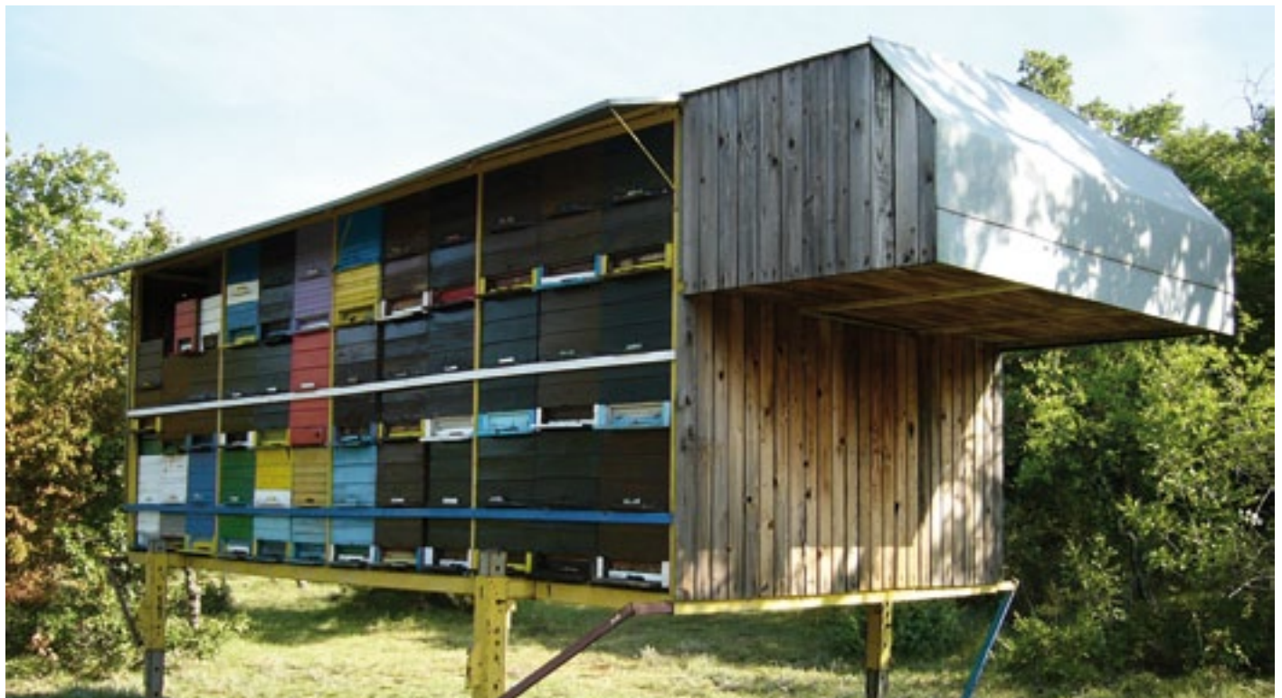
Abb. 05 - Die Magazine stehen auf einer zweiten "Ladebrücke" die abgehoben werden kann, damit der Laster den "Wanderstand per Huckepack" verstellen kann.
