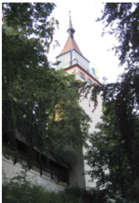
Abb. 01 Gigelturm mit Stadtmauer.
