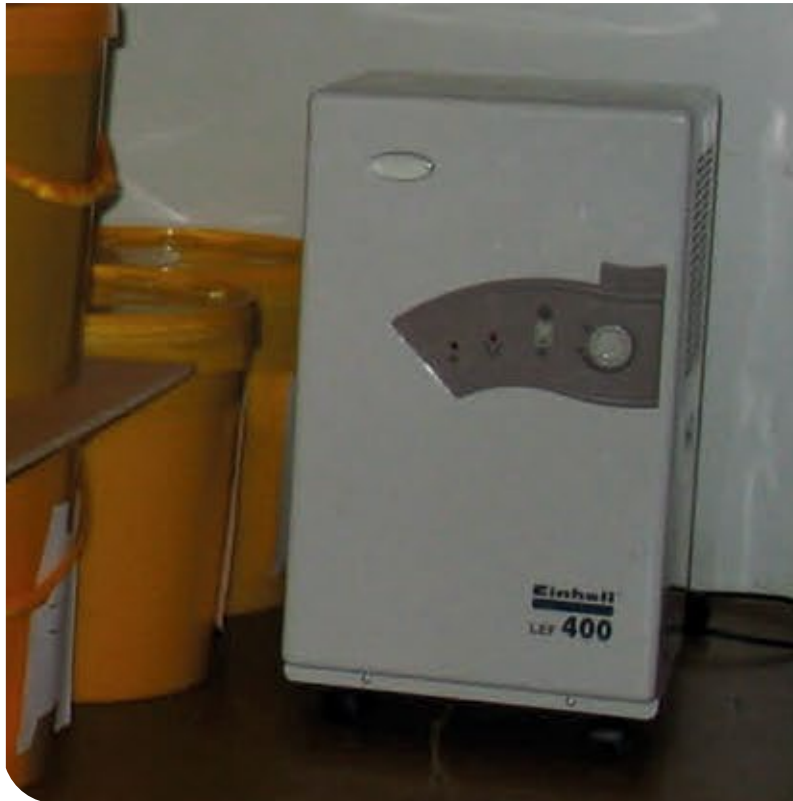
Abb. 4: Trockene Luft – im Kurzzeitlager (1-2 Tage bis zur Schleuderung), im Schleuderraum und später im Lager: mit einem leistungsstarken Luftentfeuchter z.B. der Firma Einhell (Luftfeuchte soll höchstens 55% betragen)
