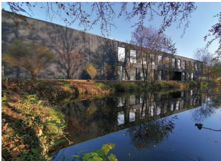
Abb. 01: Neubau der LAB oberhalb der alten Bienenkunde. Foto Dr. Rosenkranz
