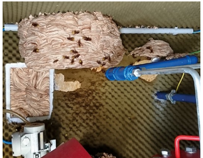
Hornissen im Container einer Gasregelstation: Die Hornissen haben sich entschieden als Ein- und Ausflughoch einen nicht abgedichteten Rohrdurchlass zu wählen. Die nebenan gelegenen Lüftungsschlitze haben sie dagegen abgedichtet. Im Bild deutlich von innen als quadratische Fläche erkennbar.
