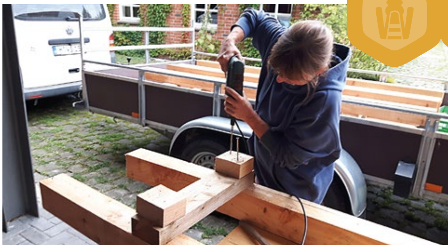
Abb. 06 - Für die neuen Untergestelle werden die zugeschnittenen Holzteile zusammengesraubt. Foto: H. Schäfer
