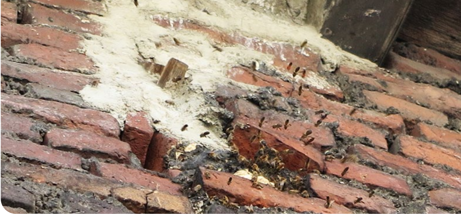
Ziegelmauer in Dortmund-Aplerbeck. Foto: 5.21© S.Knoller
